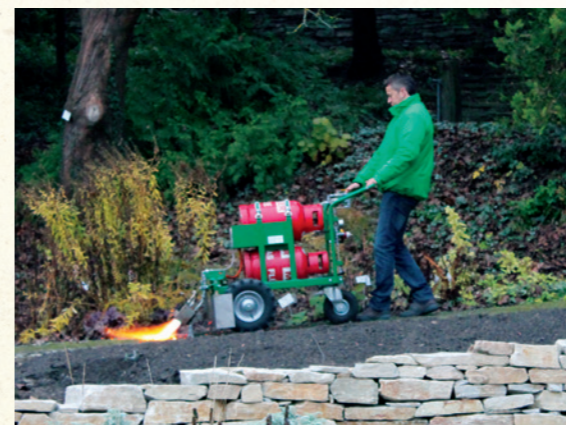
Abflammtchnik im Einsatz. Das Hitzeblech wurde zur Veranschaulichung abgenommen.
