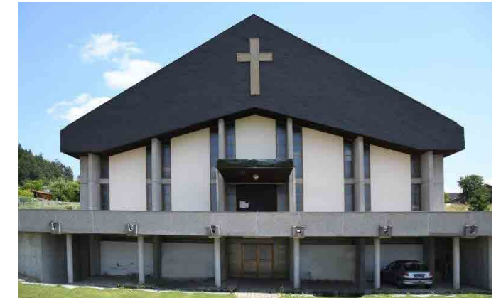
Unsere Pfarrkirche, die 1973 eingeweiht wurde und auf verschiedene Renovierungsarbeiten wartet.
