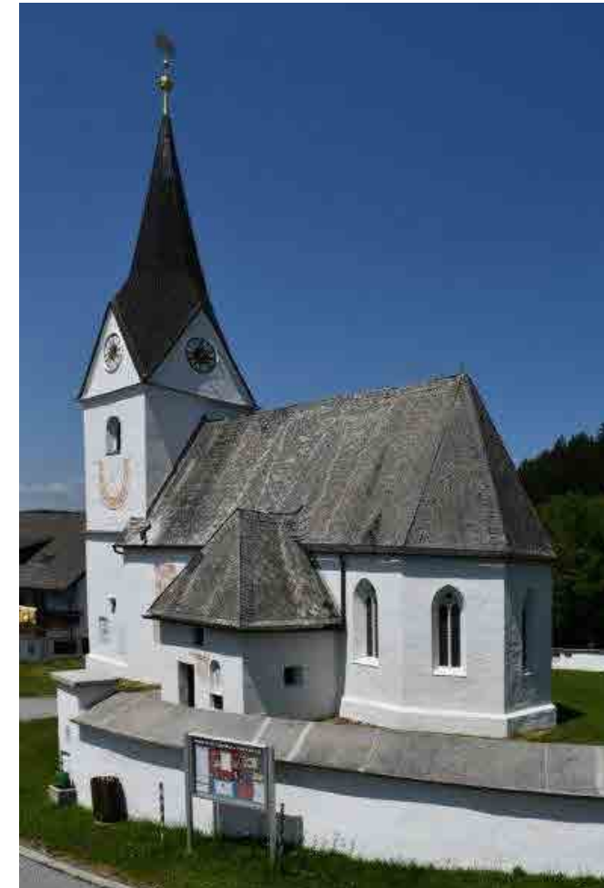
Die alte Pfarrkirche dient derzeit als Aufbahrungshalle und wurde 2018 umfangreich restauriert
