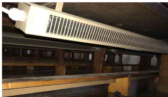
Abb. 2: Neue Heizpaneele
