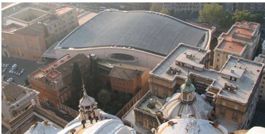
Fotovoltaikanlage auf der päpstlichen Audienzhalle in Rom
