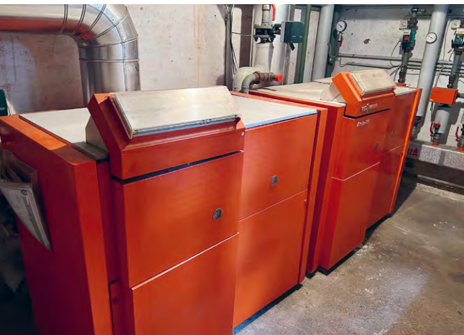
Zeitenwende im Heizungsraum Die Pfarre Maria Lourdes hat die Gasheizung (links) durch ein modernes Pelletsystem (rechts) ersetzt.
